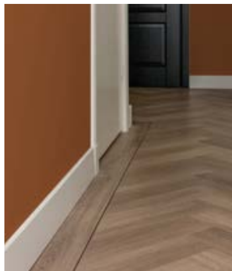
Muurplinten in de gewenste hoogte
