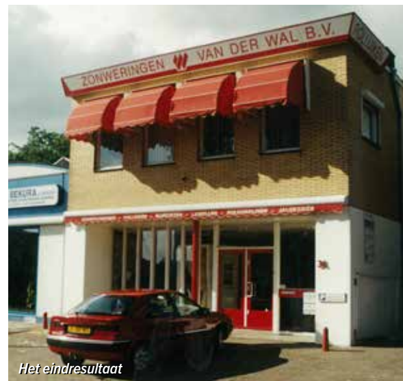
Verbouwing van de nieuwe showroom aan de Beresteinseweg
